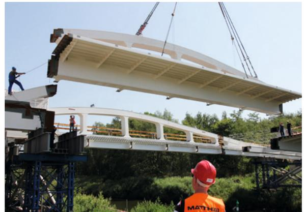
Millimeterarbeit beim Brückenbau, das Mittelsegment wird montiert.
