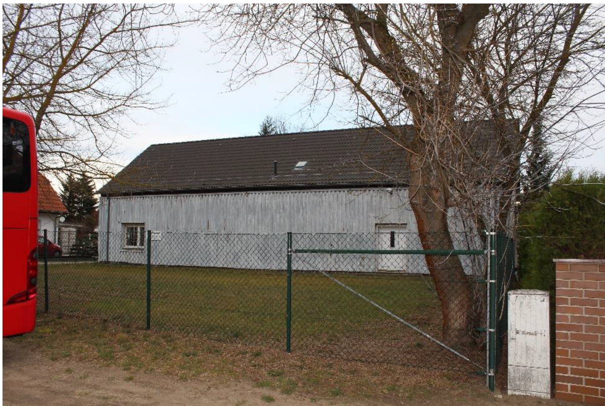
Abbildung 3: Gebäude Ansicht Buggenhagenstraße
